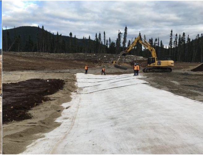
Sable à béton utilisé pour la couche de protection du géocomposite bentonitique et terre végétale de recouvrement
