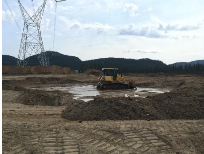
Excavation et profilage du plan d'eau peu profonde
