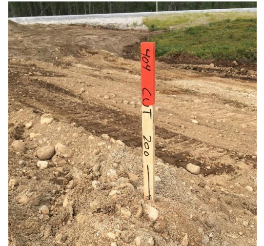
Arpentage pour le respect des élévations
