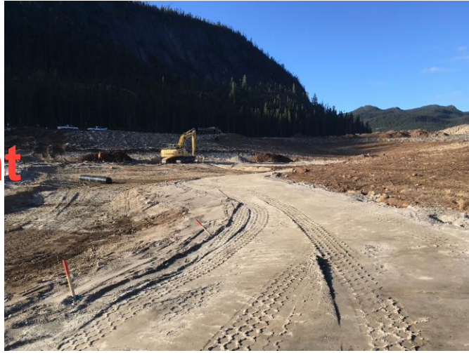
Mise en place du till dans le marais (jusqu'à l'élévation 247,4 m) autour de la zone d'eau peu profonde
